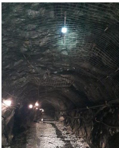
Рисунок 29 –Репера со светящимися марками ( а, б ) и в - состояние потолочины 4-орта рудника ТОО «Восход»
